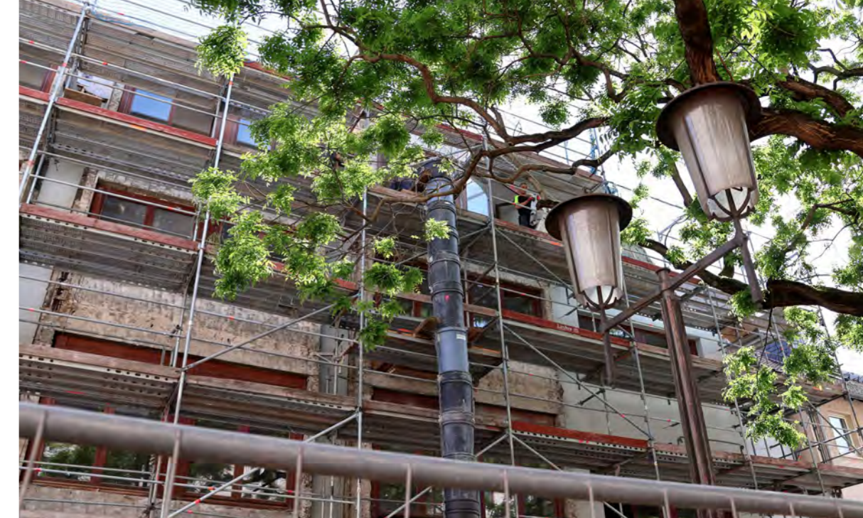
Das Spenerhaus ist eingerüstet und die metallene Fassadenverkleidung bereits entfernt.
